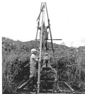
図 6 ボーリング掘削の様子 （丹後半島大フケ湿原）
