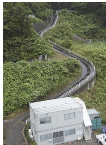
写真4 たろう観光ホテル背後の津波避難路 両サイドがスロープとなった緩傾斜構造で安全性の確保を図っている。
