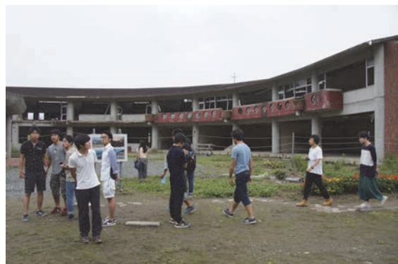
写真8 大川小学校跡での津波被害の観察
