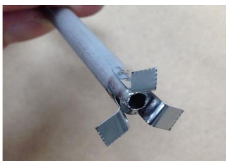
図 4-7 ステンレス板の溶接
