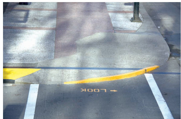
写真8 直角近接設置された横断歩道と 方向別に設置されたスロープ (Cordova St. × Howe St., City of Vancouver) 直進しての横断が容易な一方、横断歩道幅の一部 に段差が生じている。(2014年6月、筆者撮影)
