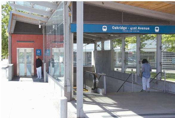
① [地上階] 駅への通路入口 (エスカレーターは上りのみ)
