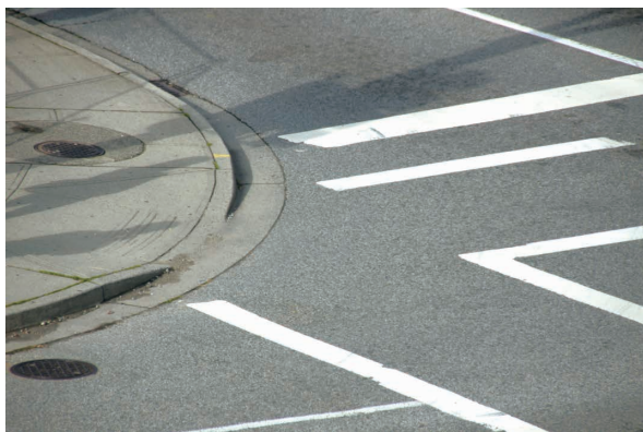
写真7 直角近接設置された横断歩道と 別方向兼用のスロープ (Holdom Av. × Lougheed Hwy., City of Burnaby) 歩道の角部分が別方向の利用者に対して有効な スロープになっている。(2013年9月、筆者撮影)
