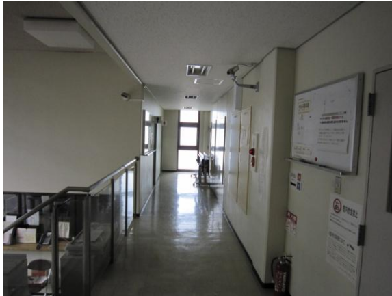
図 3 消灯された廊下
