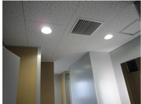
図 4 自動消灯タイプの LED 照明
