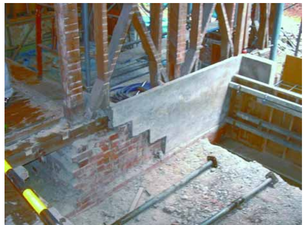
2. 第 19 旅団司令部（床下） （2009 年 11 月に武島が撮影）上方が司令部正面の入り口。床板を取り除くと、このようにレンガの土台が現れた。
