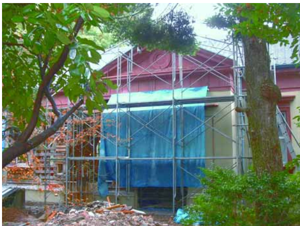
1. 第 19 旅団司令部（正面） （2009 年 11 月に武島が撮影）中央の入り口は一旦塞がれていたが、修復にあたり再度開かれた。
